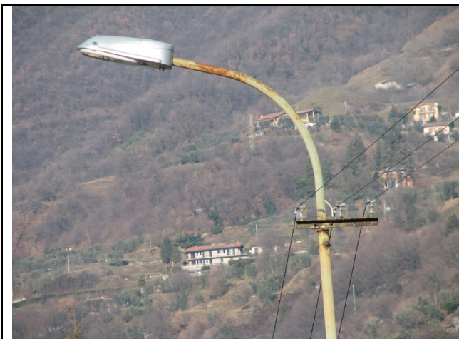
Figura 1.29 – Via Ronco – Via Pozzacher
